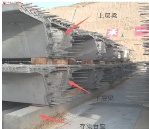
图 1 预制梁布置实况
